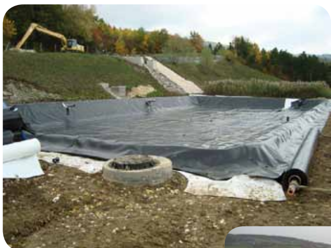
Pose de la membrane d'étanchéité
