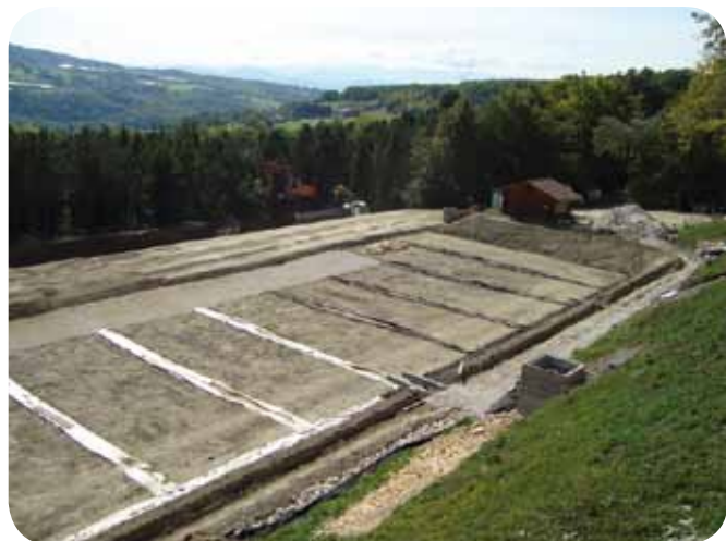
Les drains de fond du bassin
