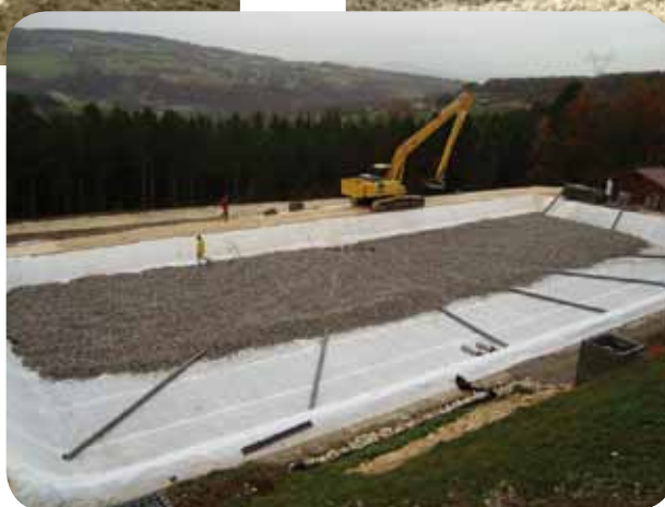
Garnissage du lit en matériaux filtrants
