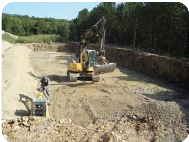
Terrassement des bassins
